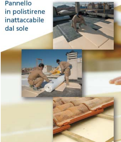
Posa del pannello P-ROOF
