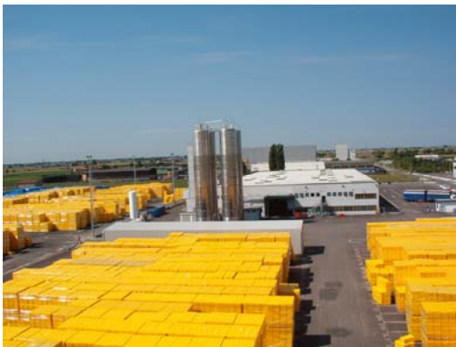
Stabilimento produttivo URSA di Bondeno (FE)
